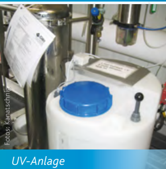
Dosierstation für Chlorlauge
