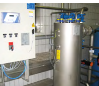
Dosierstation für Chlorlauge
